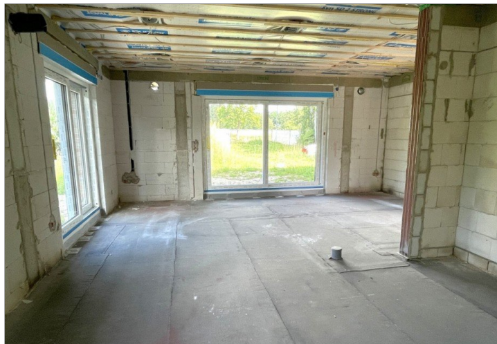
Wohnzimmer (aktueller Baufortschritt)
