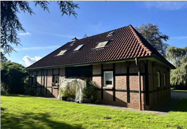
Das Fachwerk wurde erhalten..
